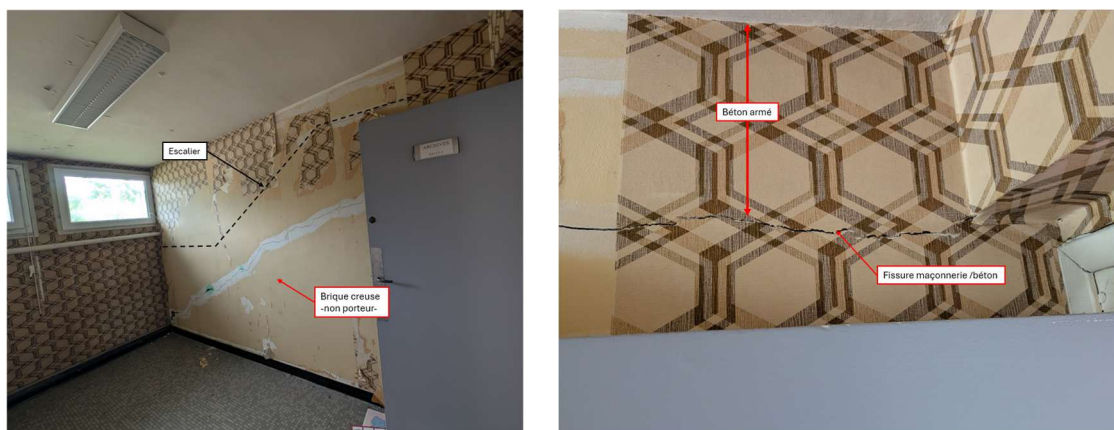
Photo 5 : Remplissage fissuré sous l'escalier
