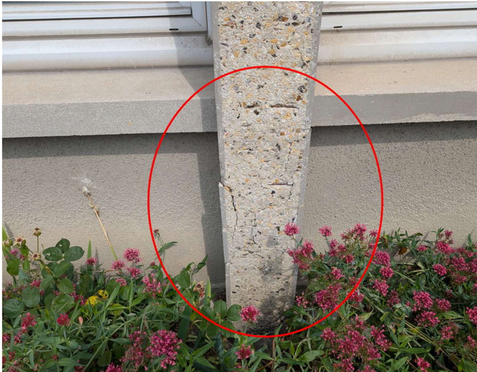
Photo 3 : Fissure du poteau coté parking, reprise à prévoir
