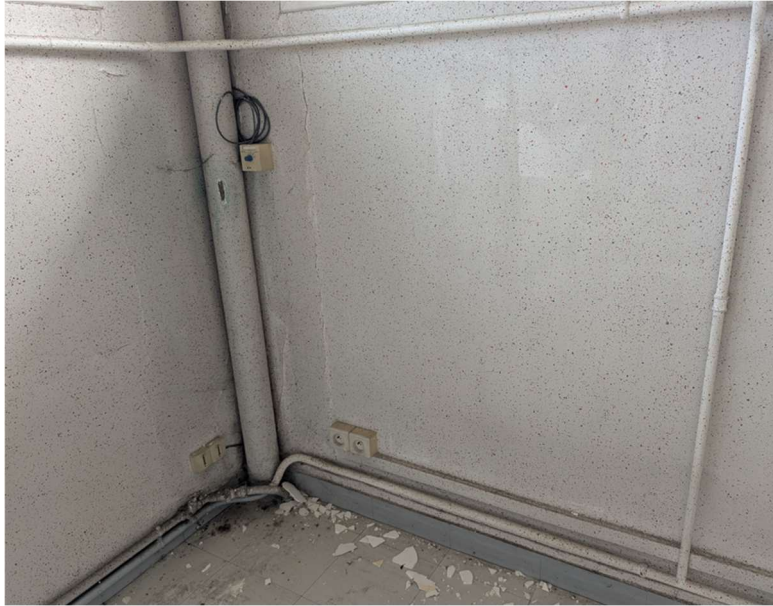
Photo 6 : Fissures entre béton et la maçonnerie
